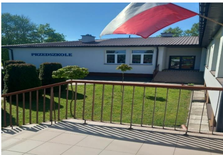
Wejście do budynku szkoły i przedszkola – Szkoła Podstawowa w Brzezinkach
