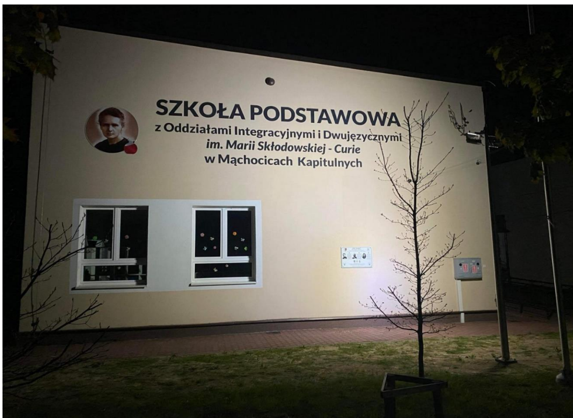
Wykonany w 2023 roku napis z nazwą Szkoły Podstawowej z Oddziałami Integracyjnymi i Dwujęzycznymi im. Marii Skłodowskiej-Curie w Mącholicach Kapitulnych wraz z podświetleniem na elewacji budynku.
